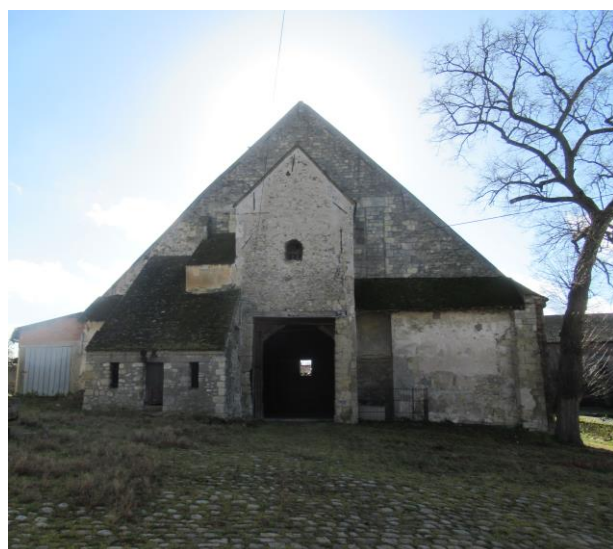
Façade de la Grange-aux-dîmes et sa cour pavée
